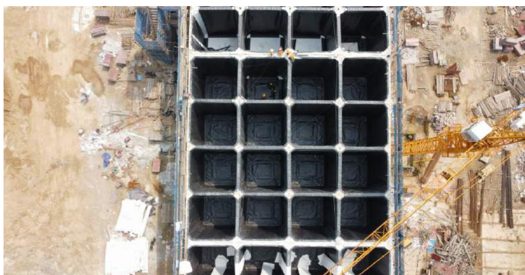
图 4-4 刚性填埋场防渗施工
