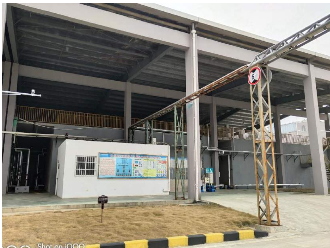
项目依托一期工程的污水处理站
