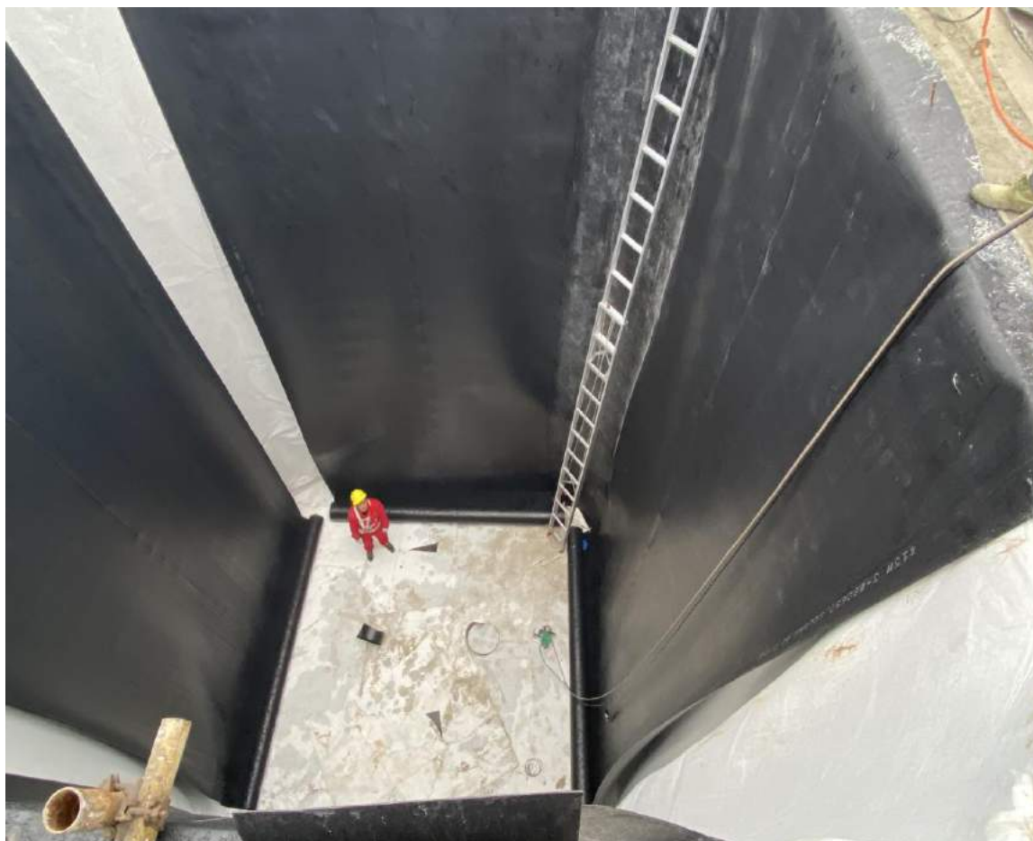
图 4-3 刚性填埋场防渗施工
