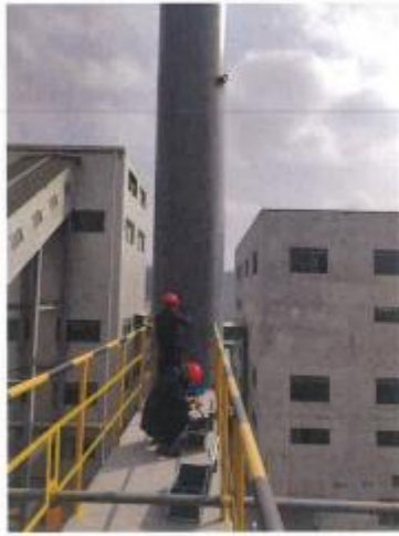
F1 选矿车间总排口
