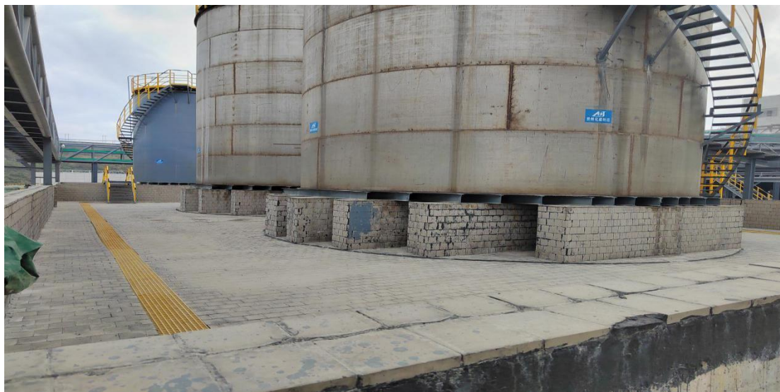
图4-7 罐区及其围堰
