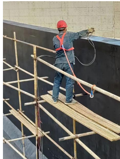
事故池和雨水池防渗工程施工照片
