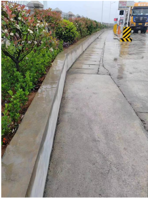
厂房四周截排水沟
