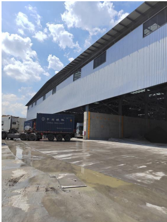
精矿库房和尾矿库房
