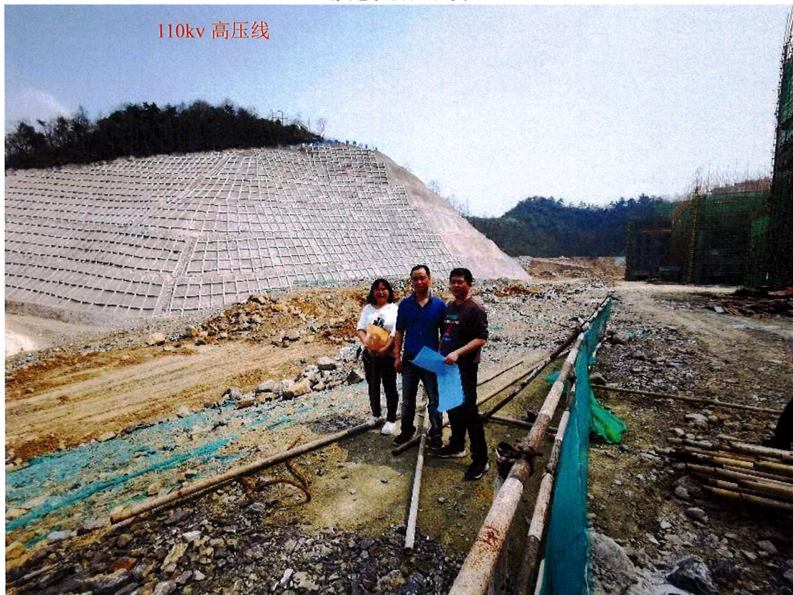
拟建项目西北側
