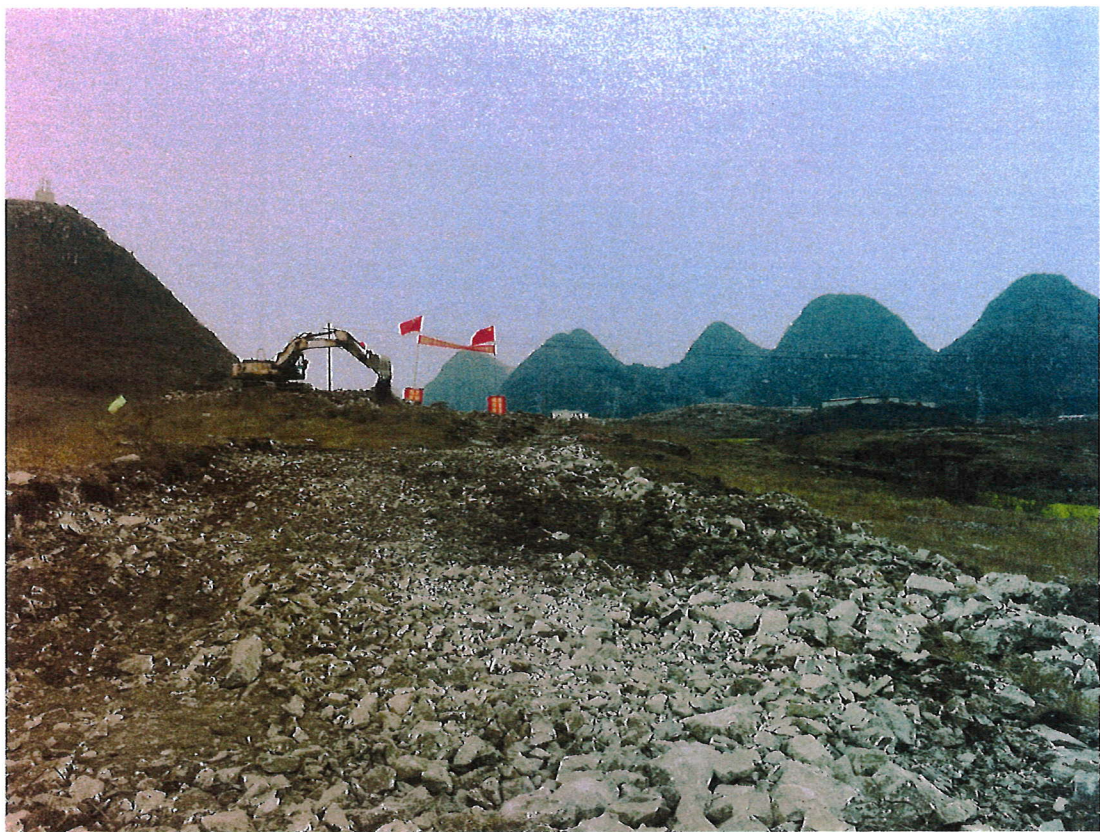
库区办公区场地
