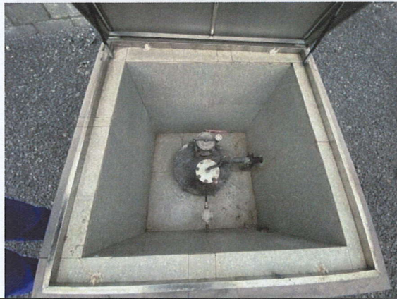
双层油罐渗漏检测报警仪
