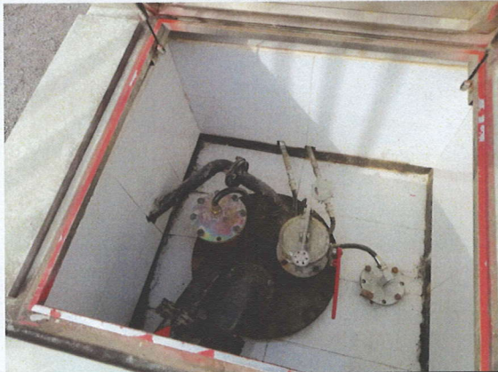
双层油罐渗漏检测报警仪
