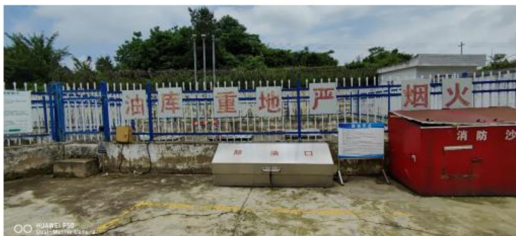
现场照片（加油站卸油口）
