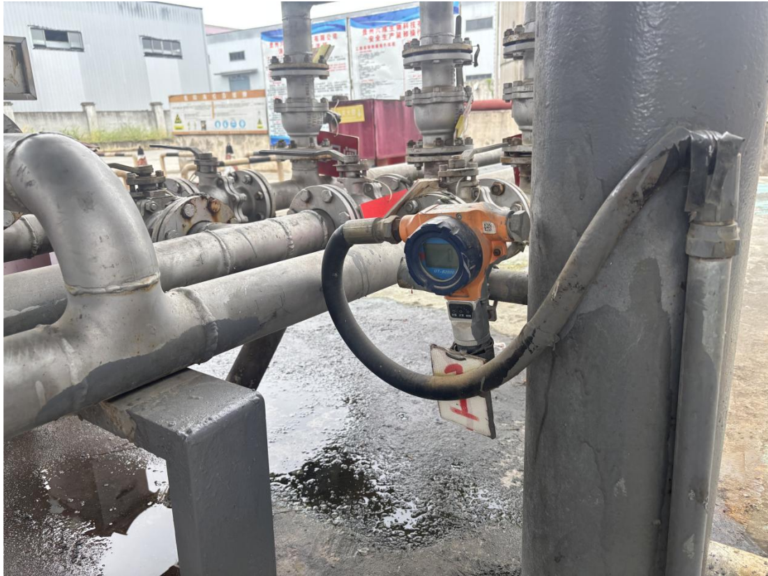
装卸栈台可燃气体报警仪
