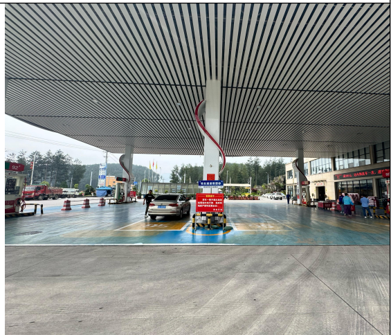
加油站加油区
