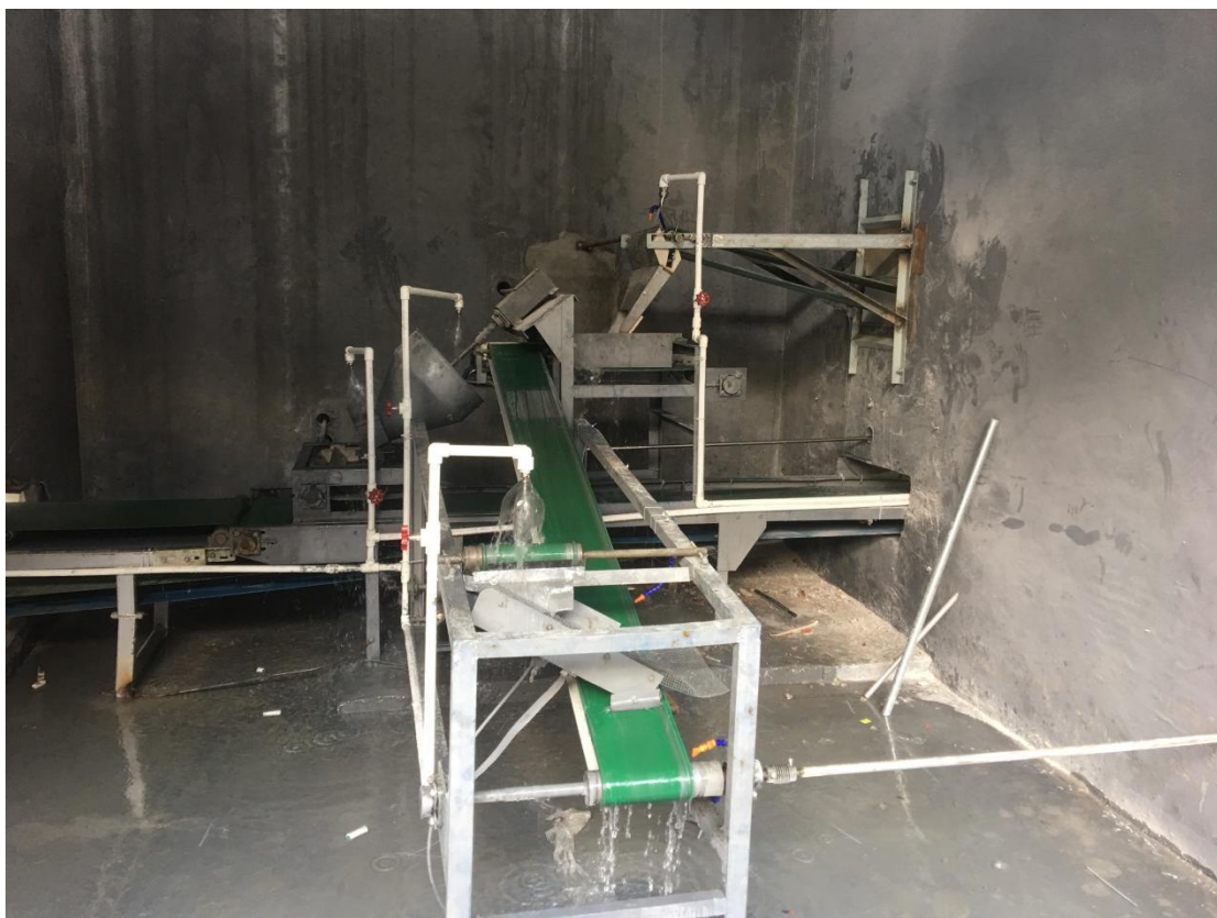
装药房改造后
