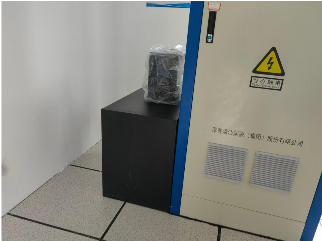
LNG 的控制柜及 UPS 电源
